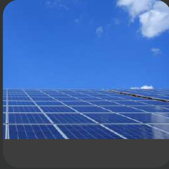
Jasper PV 96 MW
